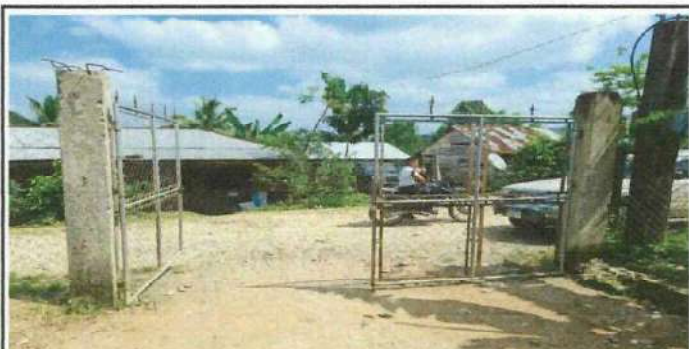
Foto 5: SUSTITUCION DE PORTONES POR DETERIORO DE LOS MISMO
