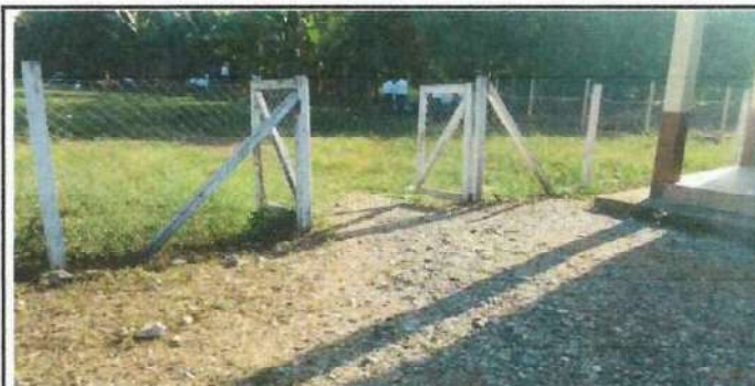
Foto 6: ELABORACION DE COLUMNAS PARA COLOCACION DE PORTON
