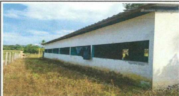
Foto1: COLOCACION DE ESTRUCTURA DE TECHO Y CUBIERTA DE LAMINA, EN EPOCAS DE LLUVIA SE FILTRA A LAS AULAS Y DETERIORA NUESTROS ESCRITORIOS PREORIDAD
